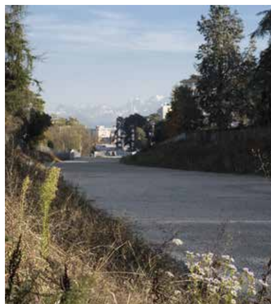
La Voie verte avant le début des travaux, une fois la tranchée couverte CEVA terminée
