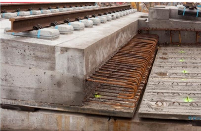
Vue en coupe d'un tronçon-test de dalle flottante, construit pour mener des essais techniques de pose de voie. La couche d'élastomère (non continue dans cet exemple) est visible dans le coin inférieur gauche. La séparation entre le radier et la dalle flottante est bien visible.
