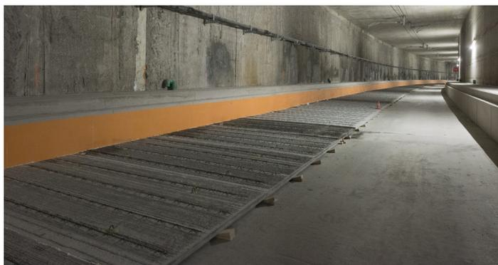
**TROIS-CHÊNE** – Dispositif anti-vibratoire: les pré-dalles sont posées sur une natte en caoutchouc (non visible sur la photo car sous les pré-dalles). Elles seront ensuite ferrallées avant d'y couler le béton de la dalle flottante.
