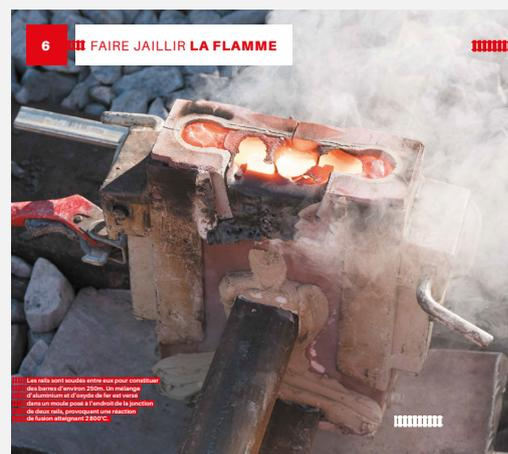
Les rails sont soudés entre eux pour constituer des tronçons d'environ 200m. Un mélange d'aluminium et d'acier de haute qualité dans un moule placé à l'extrémité de la jonction de deux rails permet de créer une section de liaison renforcée de 200cm.
