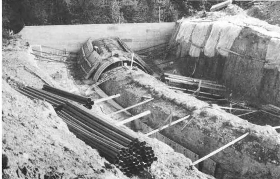
Deux vues de l'originale reconstruction du tunnel du Fiay, entre Bassins et Arzier. EN HAUT : L'ancien tunnel a été entièrement dégagé pour permettre le bétonnage de la nouvelle voûte. EN BAS : On distingue nettement le gabarit plus généreux du nouveau tunnel. Etat des travaux au 18 août 1984. Ce mode de construction n'a nécessité qu'une brève interruption du trafic.
