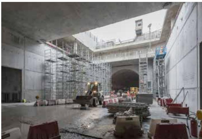
**CAROUGE-BACHET** – la trémie située à l'extrémité de la station côté TPG – on aperçoit l'entrée du tunnel de Pinchat – est en train d'être partiellement couverte. C'est ici que se dressera l'émergence en briques de verre.
