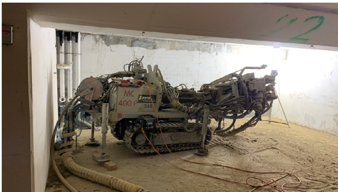
La machine qui réalise les ancrages dans l'ancien parking souterrain à la rue du Simplon.
