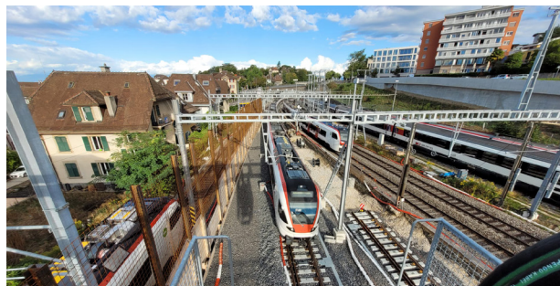
Premiers trains sur le secteur entièrement renouvelé.
