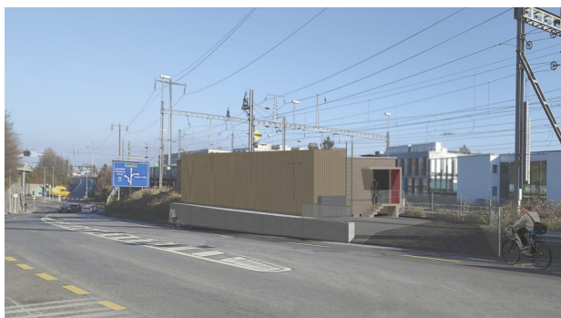
Le futur bâtiment de service qui abritera l'enclenchement de Morges.
