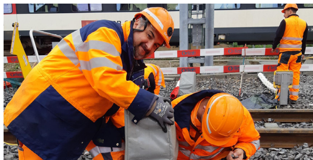
Préparation de la mise en service du faisceau.
