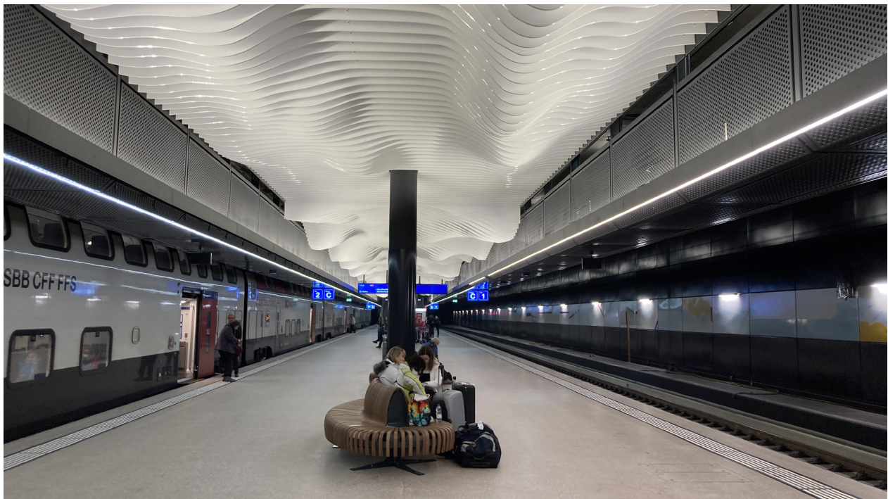
La gare Genève-Aéroport avec ses nouveaux quais et son plafond unique.
