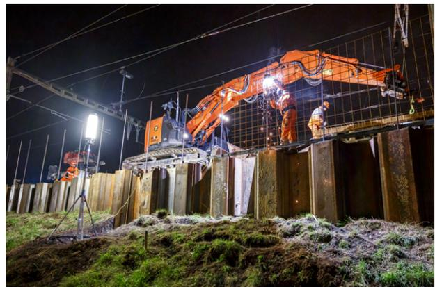
Durant plusieurs mois, les ouvriers ont construit le nouveau mur de soutènement au sud-ouest de la gare. Cet ouvrage, en plus de renforcer le sol, accueillera à terme une paroi antibruit et permettra d'élargir le faisceau de voies vers le sud.
